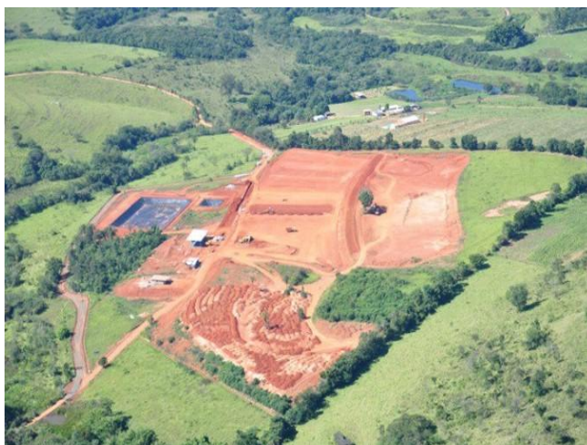
Foto da obra do Aterro Sanitário São Sebastião do Paraíso/2012
