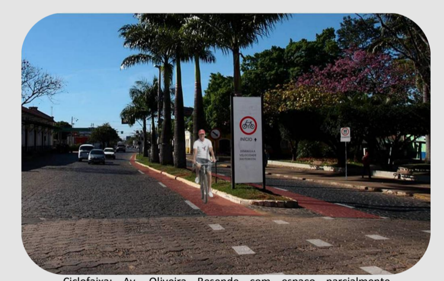
Ciclofaixa: Av. Oliveira Resende com espaço parcialmente segregado para ciclistas. Linhas de bordo delimitam a ciclofaixa.
